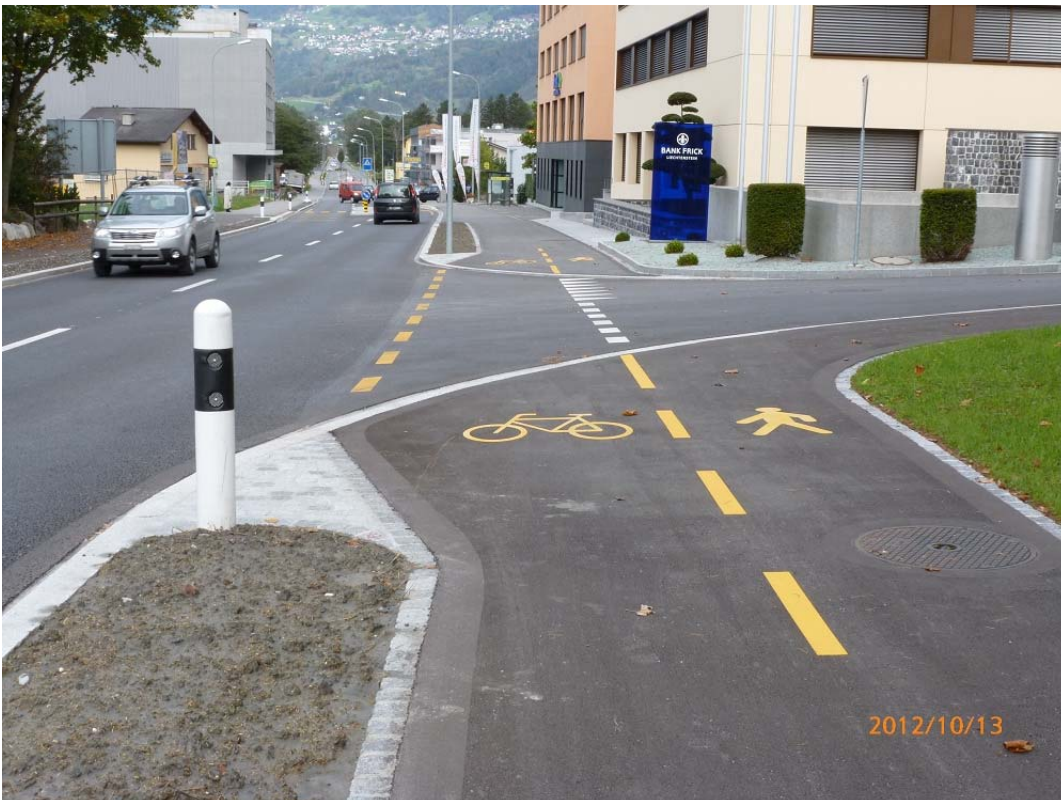
Balzers Landstrasse–Stötz: 3 cm hohe Kanten bei einmündender Strasse; ebenfalls bei der Einmündung Alte Landstrasse.
