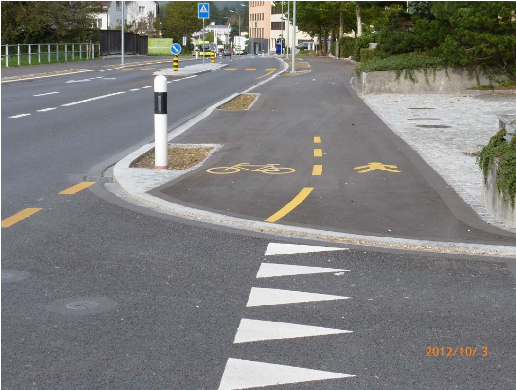
Balzers Landstrasse–Ramschwagweg: 3 cm hohe Kante beim Beginn des Radwegs.
